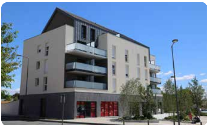
Port-Jérôme-sur-Seine - Rubano - Architecte B112
