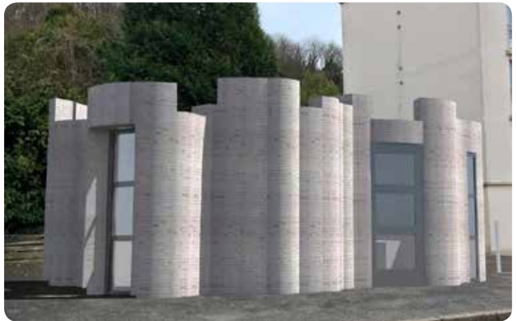
Le projet d'espace d'accueil des locataires à Harfleur, construit en impression 3D
