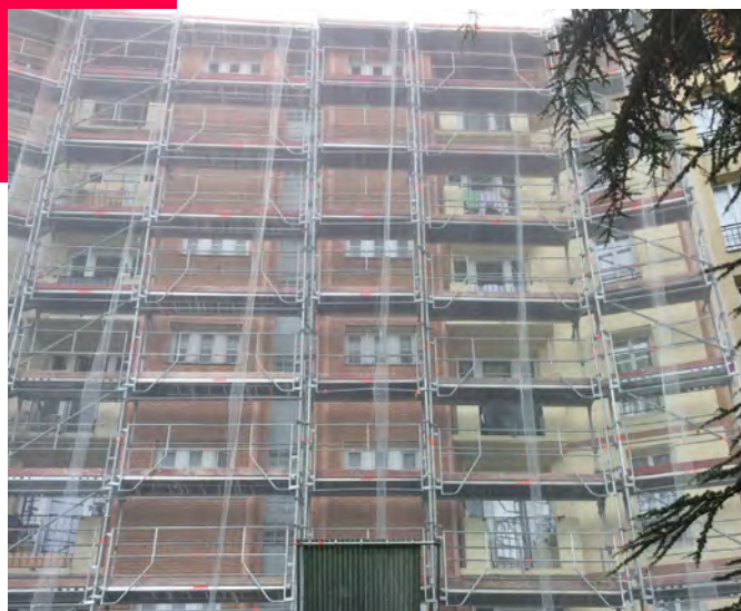
Rénovation thermique à Vitry-sur-Seine (Val-de-Marne)
