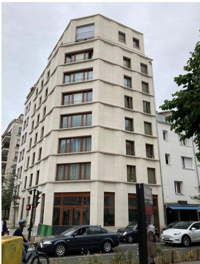
Construction d'un immeuble en R+8 composé d'un commerce au rez-de-chaussée et de 12 logements dont 2 duplex de type F5, 4 F2 et 6 F3. Chauffage individuel gaz (les chaudières sont situées dans les locaux sur les paliers).
