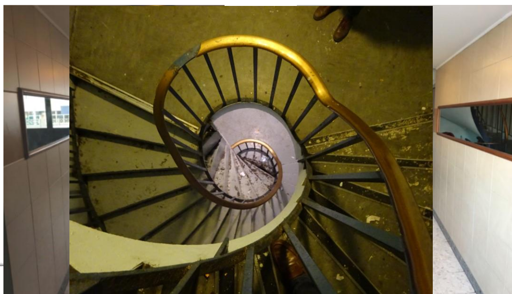
1125L – L'Hay Les Roses – avant travaux
