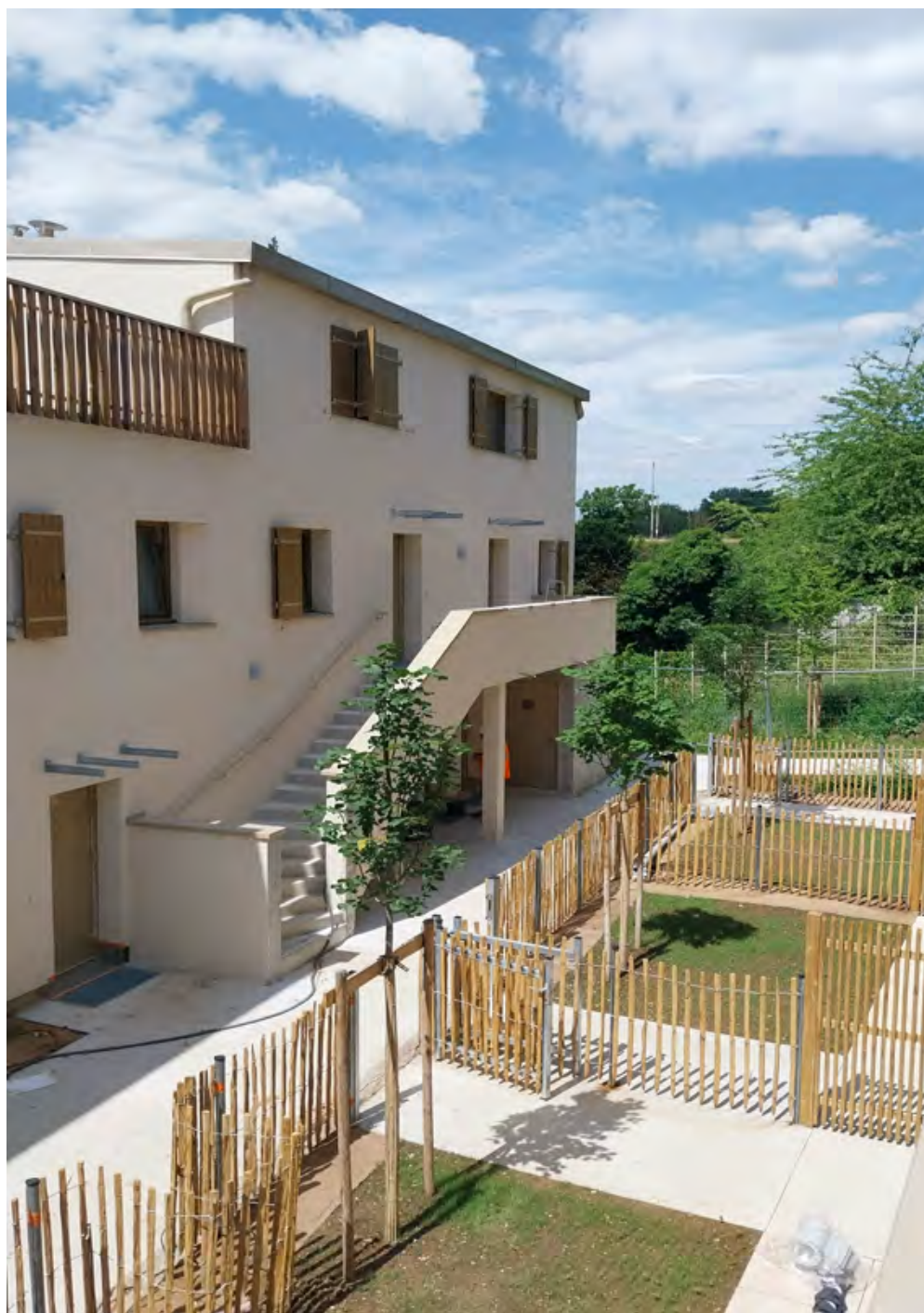
TRILPORT (77) – Résidence 1 rue du Port Architecte : entreprise Touraud 34 logements, construction bas carbone et hors site.
