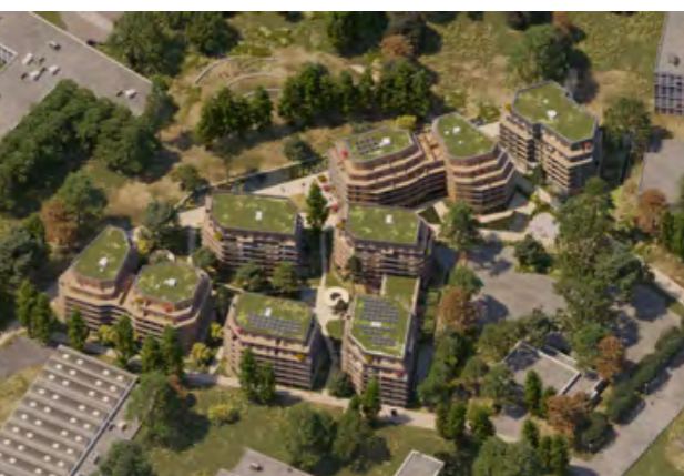
CACHAN campus (94 230) – Avenue du Président Wilson – Immeuble Canopée, 55 logements et 2 commerces
