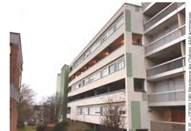
© 3F – CERGY (95) Résidence les Chênes, A&B Architectes
