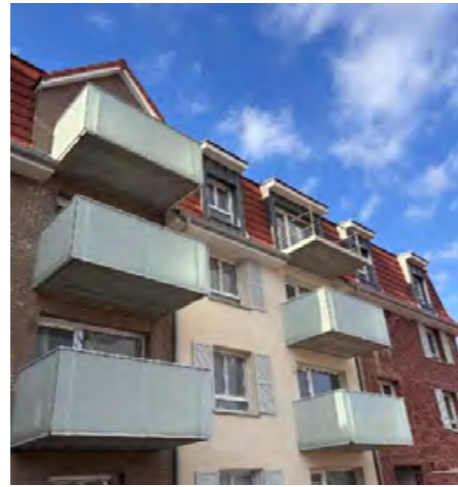
LINSELLES (59) – Résidence "Le Fil du lin" dans la métropole européenne de Lille, sur une friche industrielle de l'ancienne usine Peaudouce, 63 logements : 43 en locatif social et 20 en prêt social location-accession (PSLA)
