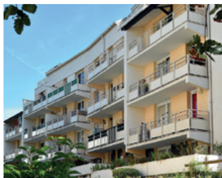
MONTMAGNY (95) Val d'Oise Rue des Carrières/Rue de Pierrefitte
