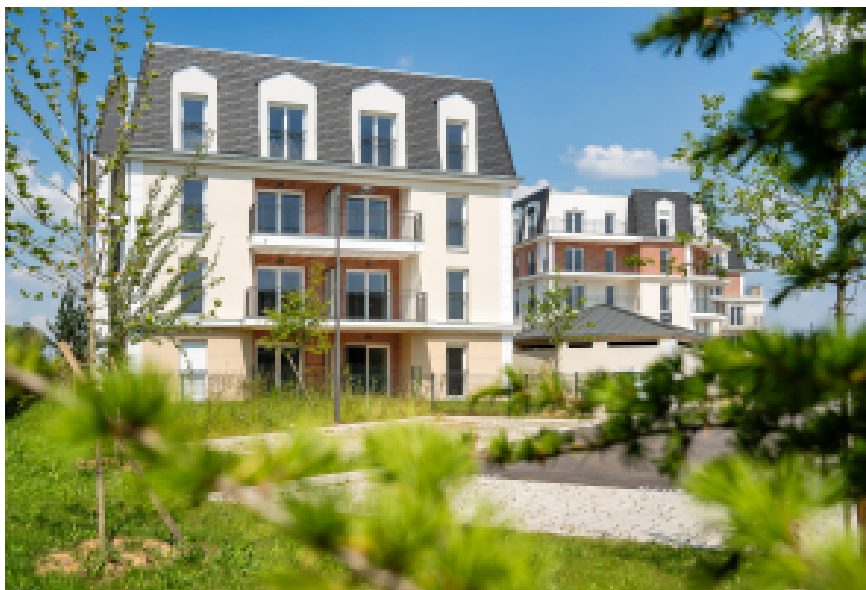
Résidence intergénérationnelle à Osny (95)
