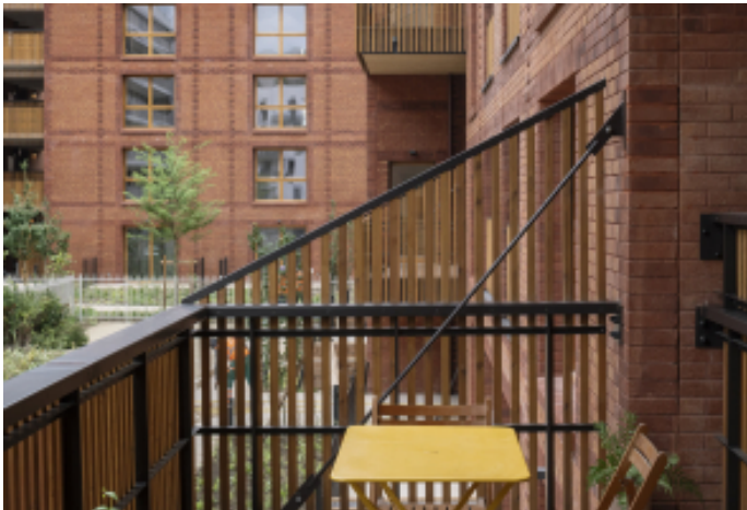
76 logements à Bagneux, opération lauréate du prix Habitat de l'Equerre
