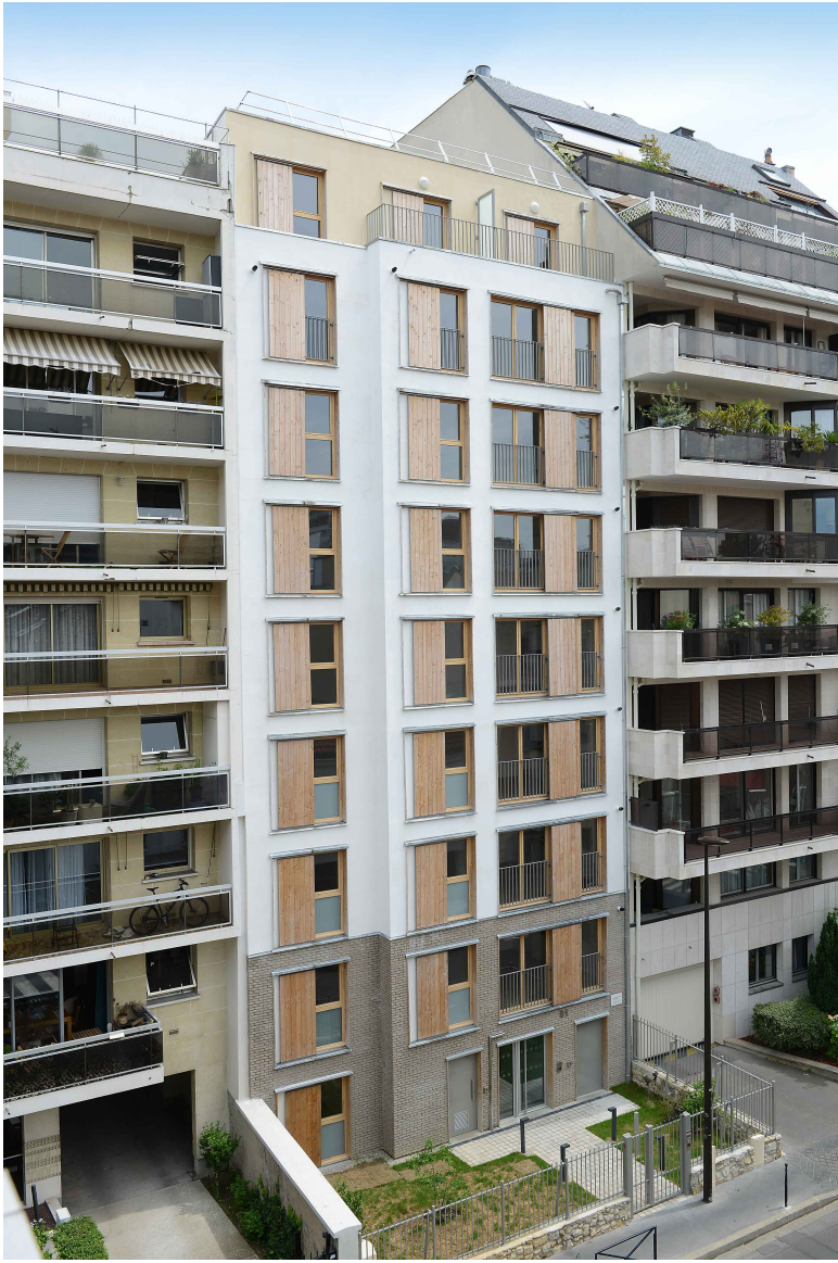
Boulogne-Billancourt (92) : programme de 15 logements sociaux construit avec du béton de chanvre
