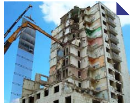
Démolition de la tour 17 en 2009
