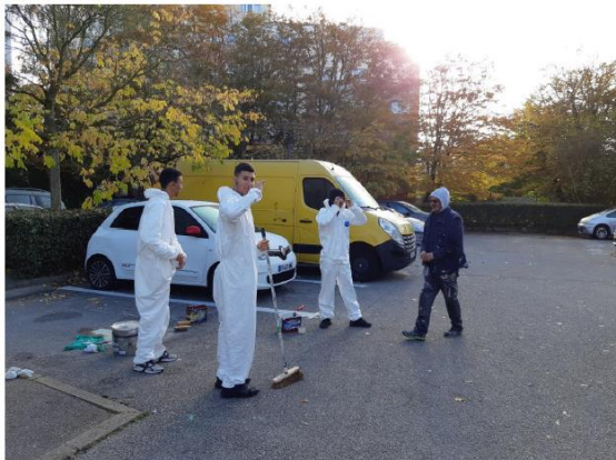
Remise en peinture parking et locaux techniques
